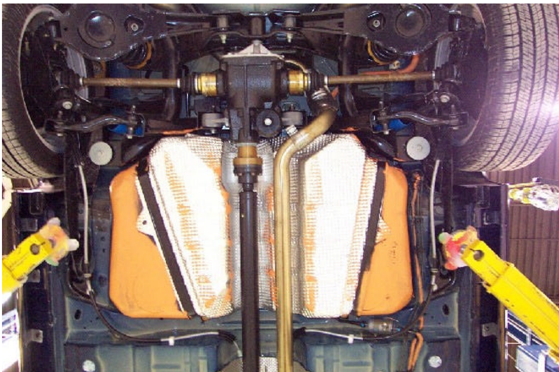
41. Réservoir de carburant. Fuel tank.
