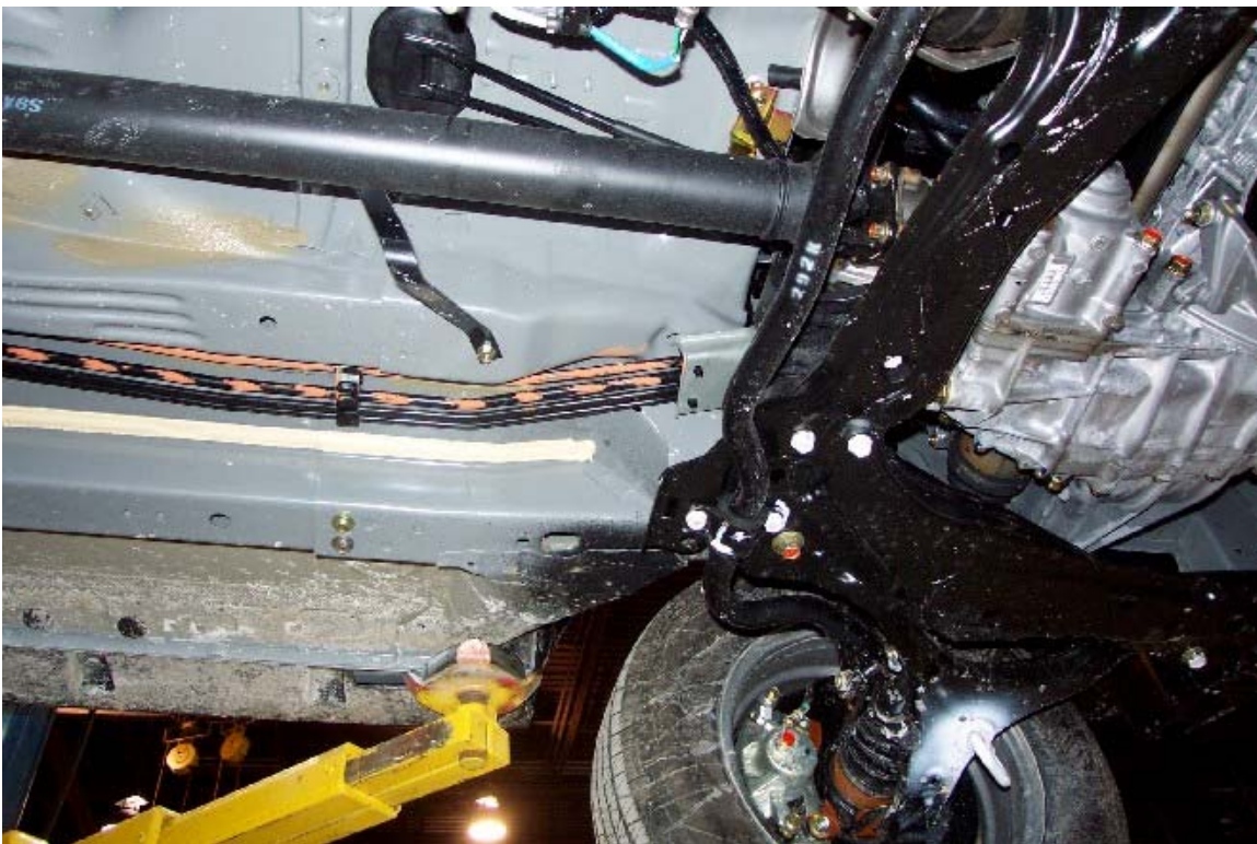
34. Lignes de carburant et vapeur. Fuel and vapor lines.
